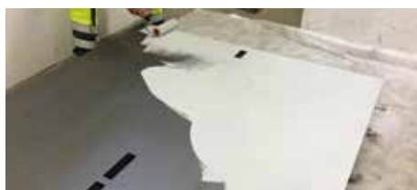
▶ 2. Grundierung (mit Rolle)
